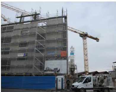
Un chantier à Renens. MTI/Photo prétexte
